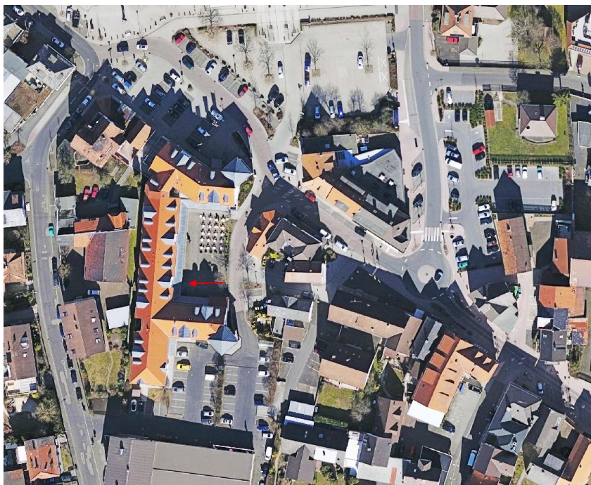
Luftbild des Objekts (der Pfeil markiert den Eingangsbereich)
