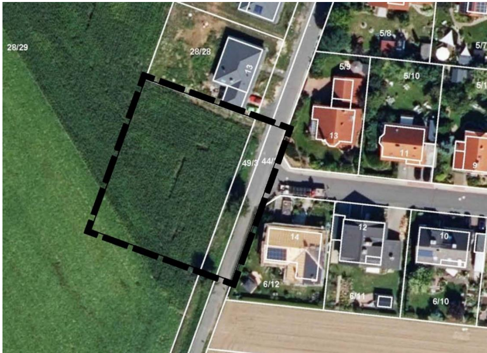
■ Abbildung 5: Luftbild Plangebiet
